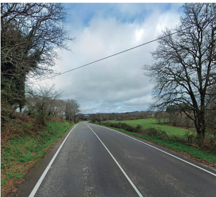
Un tramo da estrada DP 4604 onde se reforzará o pavimento. / Foto: Cerne
