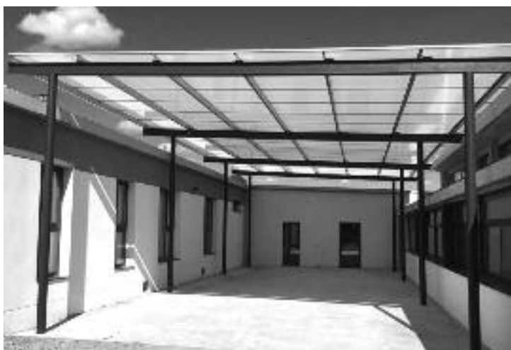
Cuberta instalada este verán no patio do CEIP de Toques
