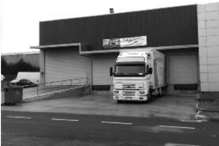
Entre as naves afectadas está un almacén de froitas
