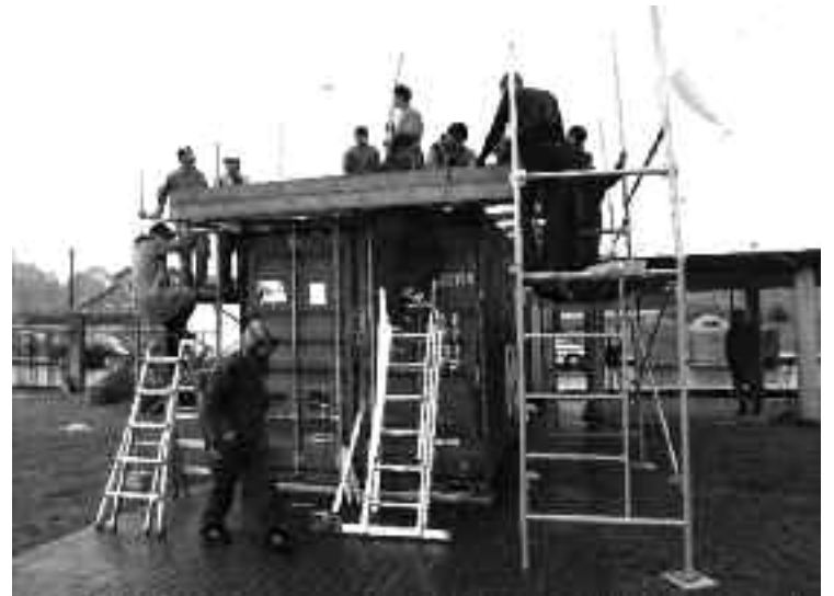
Alumnos traballando para acondicionar o contedor marítimo
