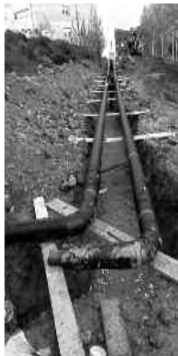
Soterramento da tubaxe con illante térmico
