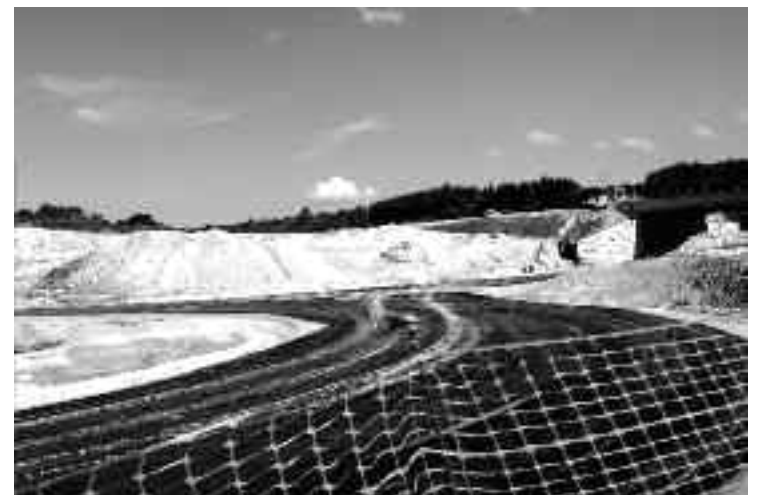
Estado das obras en San Xulián do Camiño (Palas de Rei)
